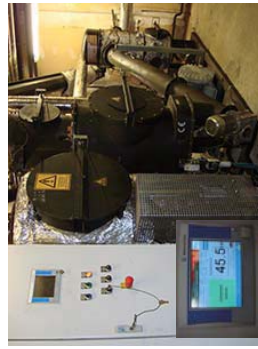
Spanner社の45kW × 2台=90kWの電力と220kWの熱を19戸へ供給
