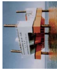
沖縄県八重山郡西表島サハ沖 出力:1~12kW (振り子式)
