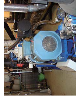
Spanner社の45kW × 2台=90kWの電力と220kWの熱を19戸へ供給
