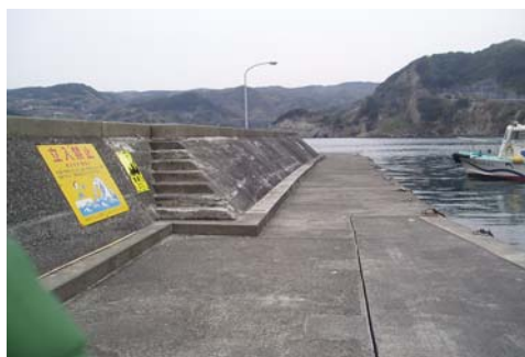
(防波堤撤去箇所)
