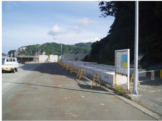
(ブロック製作ヤード)
