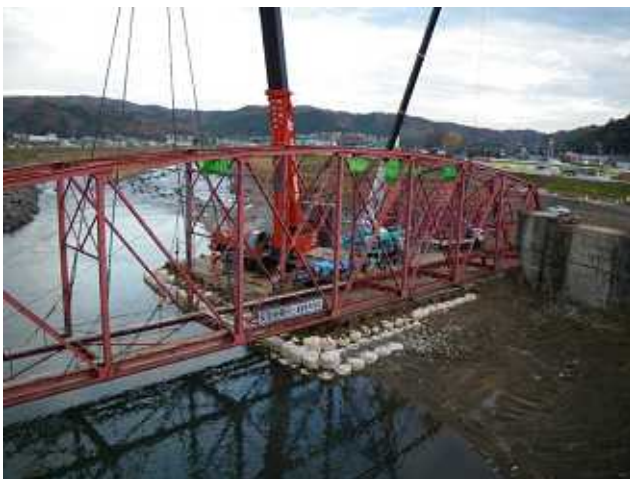
550tクレーン1台による移動
