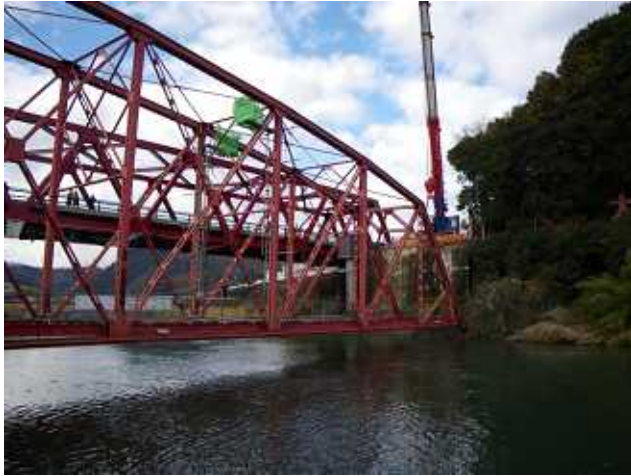
共吊りによる降下作業
