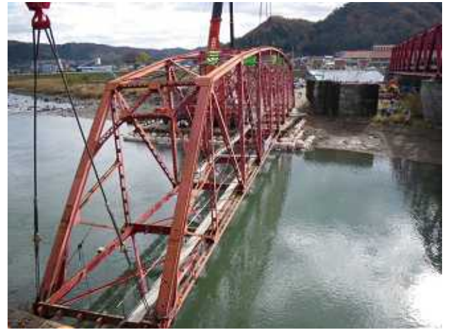
共吊りによる降下作業
