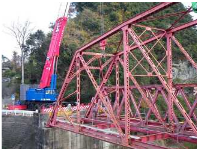
200tクレーン作業足場
