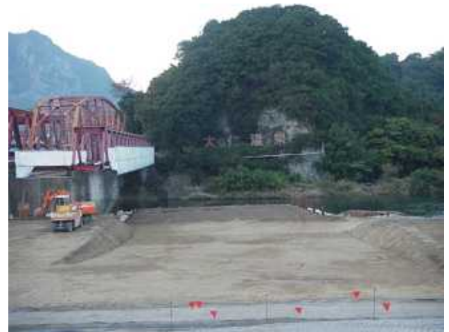
550tクレーン作業構台
