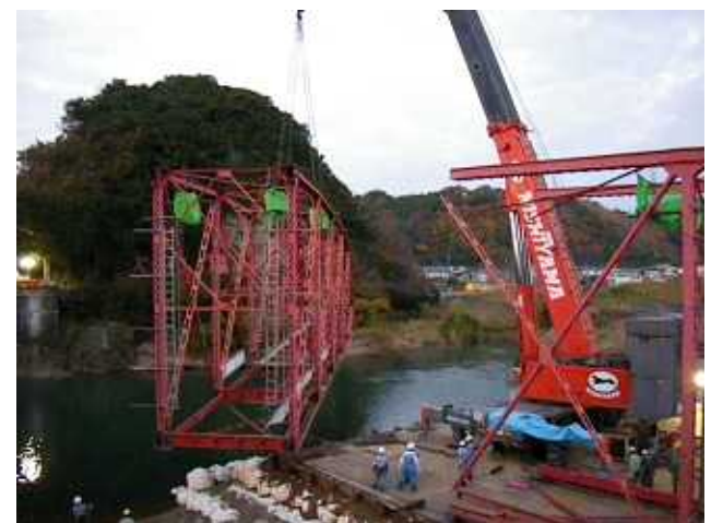
550tクレーン1台による移動
