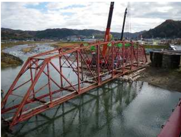
共吊りによる降下作業 550tクレーン側
