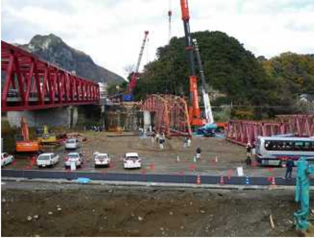
施工状況前景
