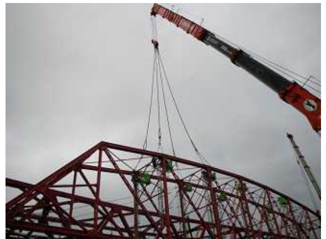
吊り金具設置位置
