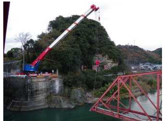
共吊りによる降下作業 200tクレーン側
