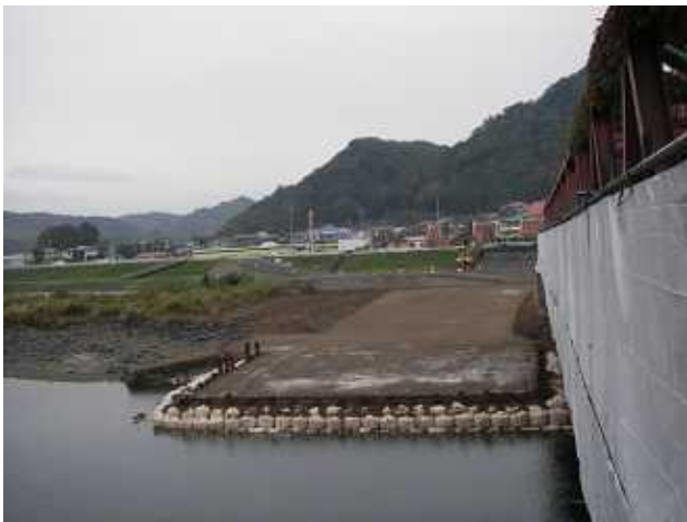
550tクレーン作業構台
