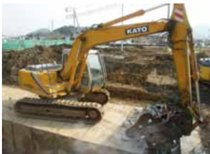
圧碎機による取壊し (振動・騒音対策の取組み)
