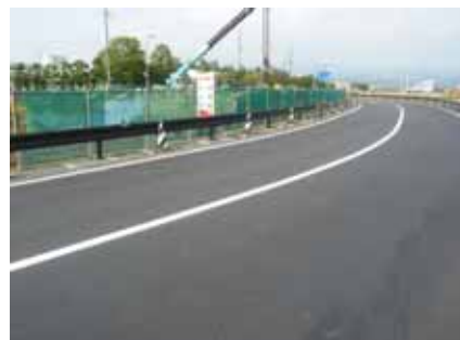
ネットフェンスによる仮囲い { 日々の作業終了時に運転者の視界を遮らないよう飛散防止用のネットを外す }
