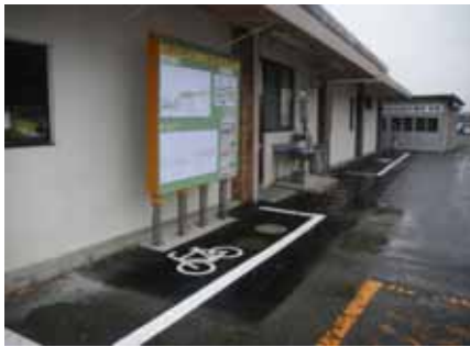
工事報告看板 全景 (塚本公民館)
