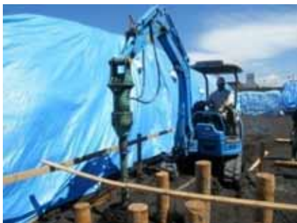
オーガーによる削孔状況
