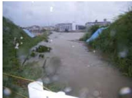
台風の影響による既設水路上流部の様子
