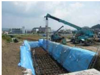
モンケンによる打込み状況
