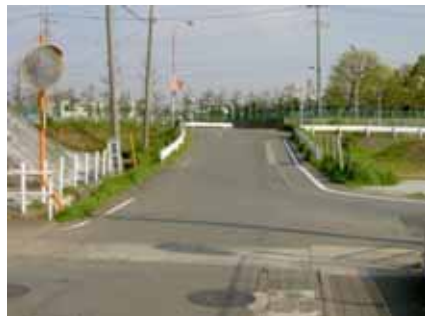
水路の施工を行う町道の様子
