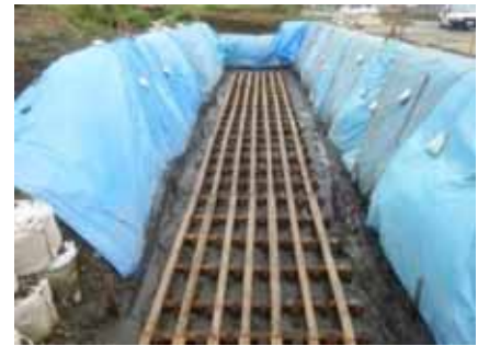
梯子胴木組立完了全景
