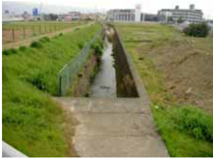
普段の既設水路上流部の様子
