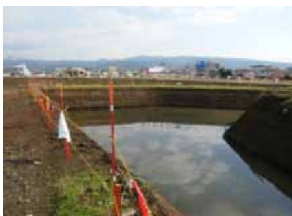
県下水道用地への調整池の設置
