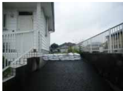
浸水時に備え土のうを配布・設置
