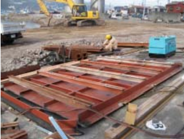
写真-1 水中型製作状況
