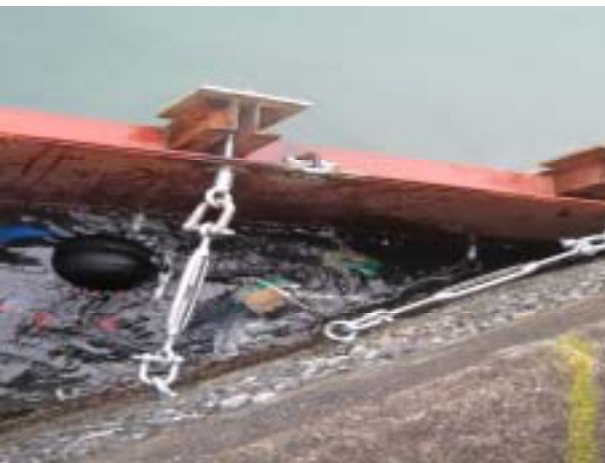
写真-2 水中型枠取付状況
