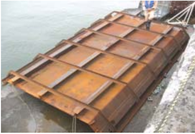
写真-1 水中型枠
