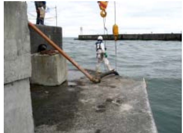
写真-5 水中コンクリート打設状況
