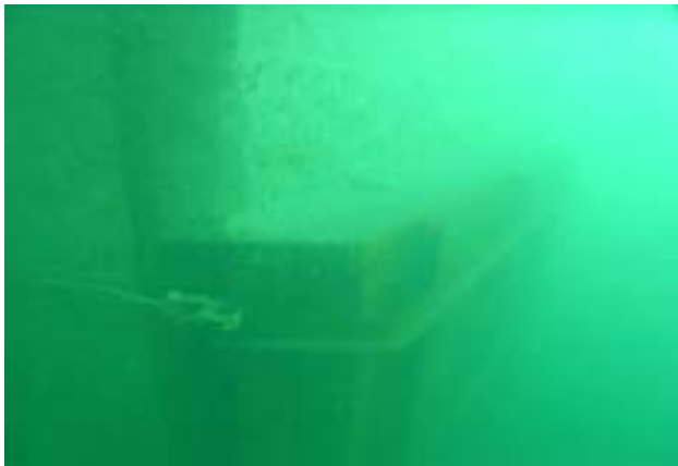
写真-2 水中型枠設置(水中)状況
