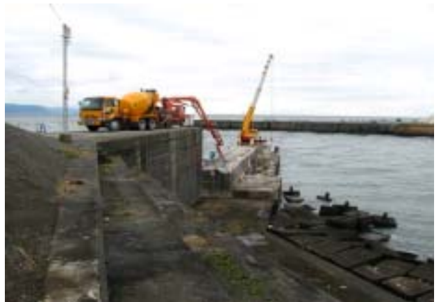
写真 - 4 コンクリート打設機械配置状況
