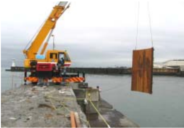
写真-2 水中型枠設置状況
