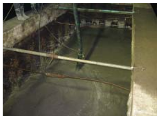
写真-6 水中コンクリート打設状況
