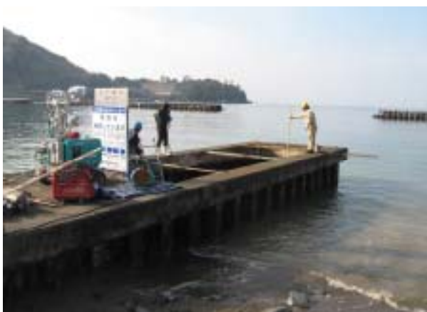
写真-5 捨石均し状況
