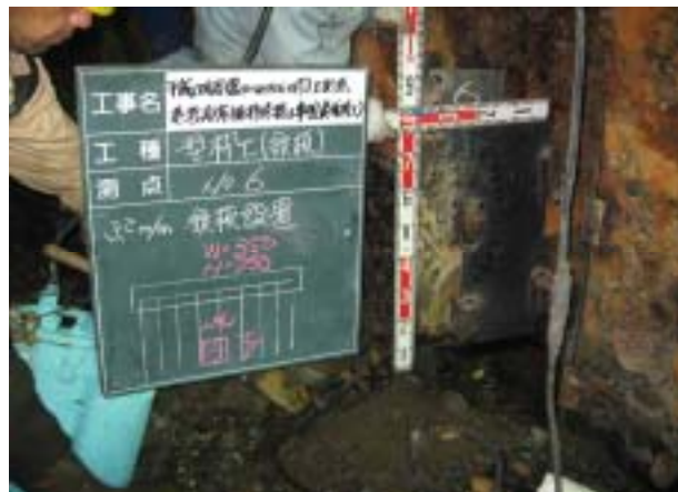
写真-4 矢板腐食部溶接完了
