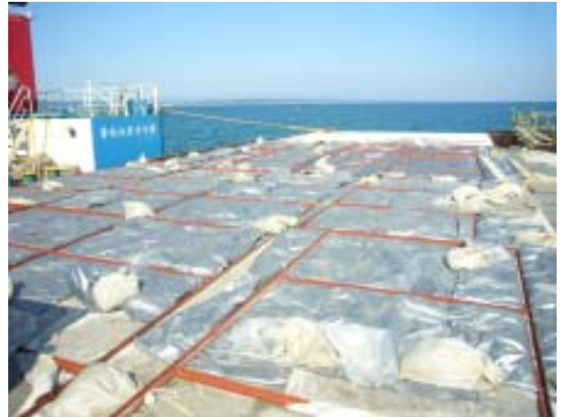
飛散防止枠設置
