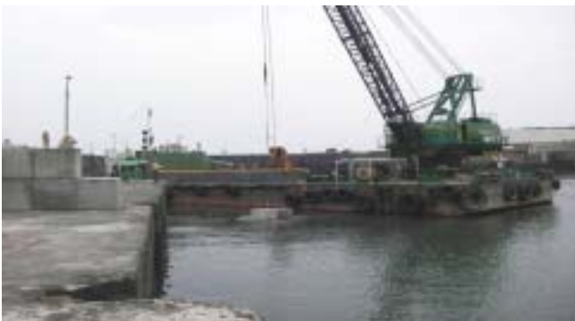
写真-1 方塊据付状況
