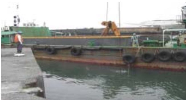
写真-2 方塊据付状況
