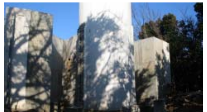
写真-8 既設建物(附属舎)改修
