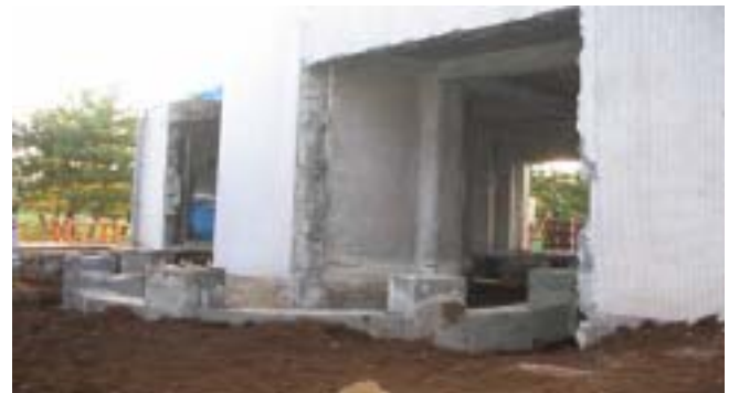
写真-6 支柱基礎・埋戻し
