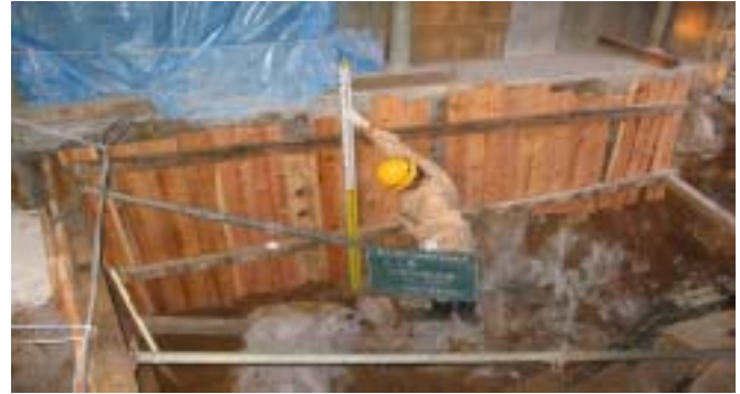
写真-5 掘削時土留設置
