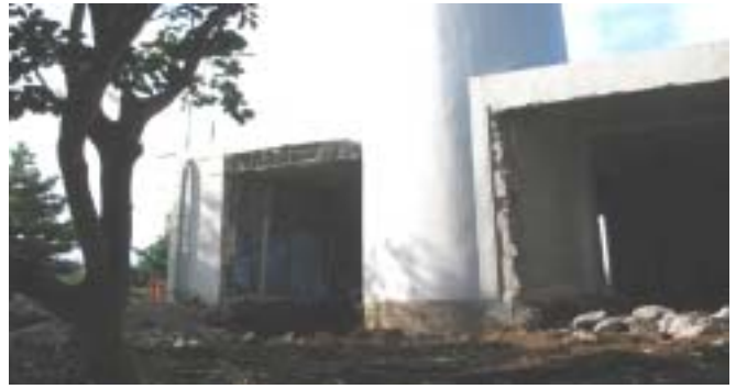
写真-4 既設建物土間・壁解体
