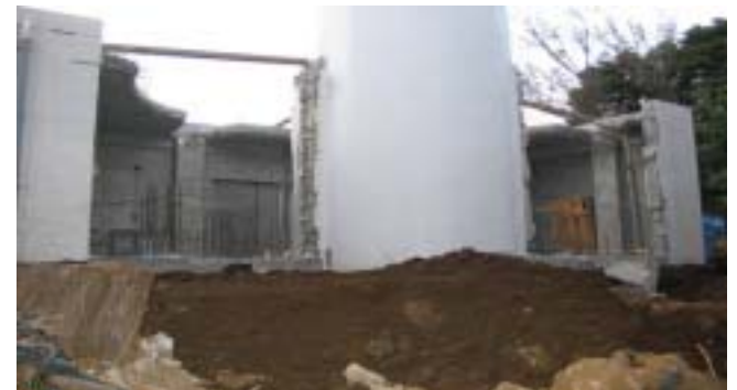
写真-7 既設建物(スラブ)解体
