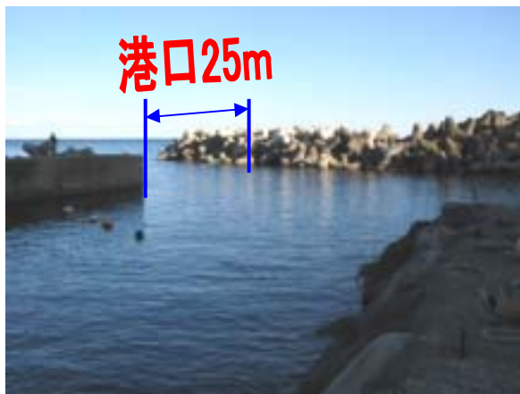
写真-1 着手前、内港側(施工箇所)から沖側を望む
