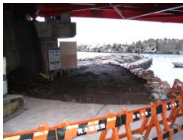
写真-7 仮設道路造成、完了状況
