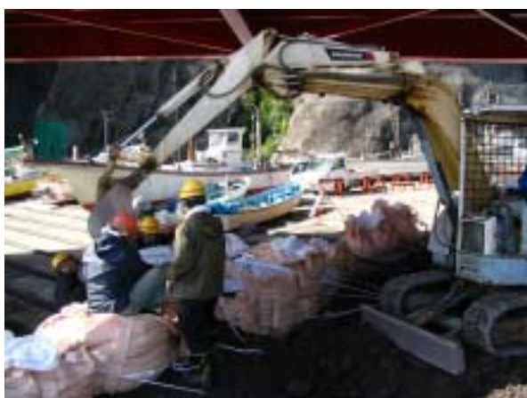
写真-5 仮設道路造成、土嚢製作ロープ固定状況
