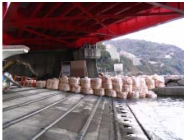
写真-6 仮設道路造成、土嚢設置完了状況
