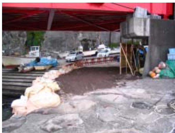
写真-8 仮設道路造成、完了状況
