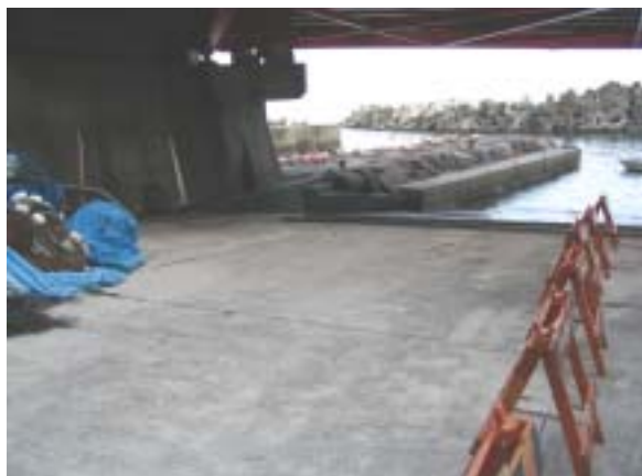
写真-2 着手前、船揚場から施工箇所を望む(上側は橋桁)
