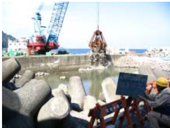
写真-4 港外側よりの200t吊起重機船裏込石投入状況
