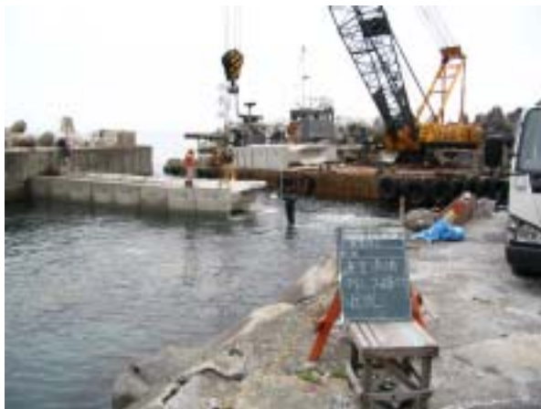
写真-3 港口での70t吊起重機船ブロック据付状況
