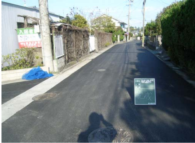
完成写真(No. 17よりNo. 16方向を望む)
