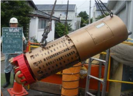
掘進機吊降し
