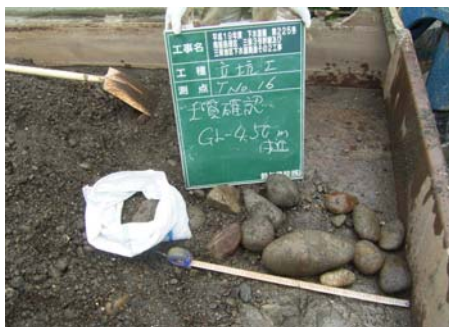
立坑築造時土質確認
