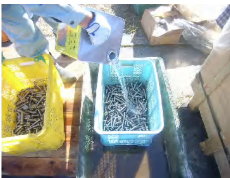
摩擦増大マット用アンカーピン防製剤施工
