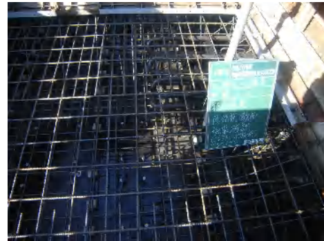
防製剤効果:摩擦増大用マットアンカーピン 横引きアンカーホルト
