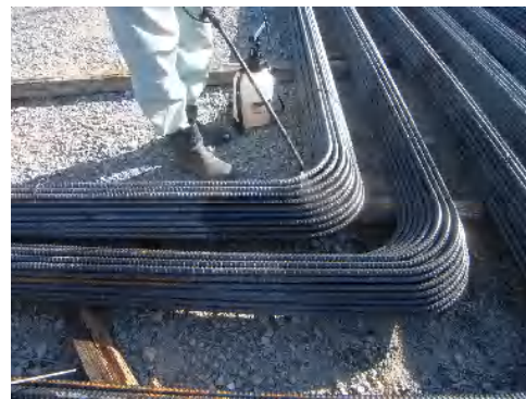
鉄筋加工時、防製剤散布状況
