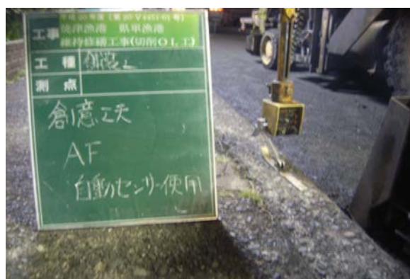
写真⑥ アスファルトフィニッシャー自動センサー
