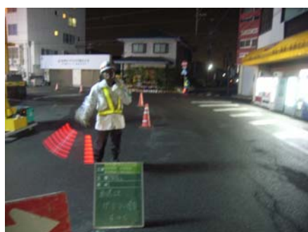
写真⑤ 誘導員設置
