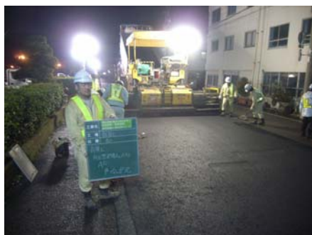
写真④ 照明設置状況
