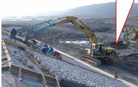
法面部の石張り施工
