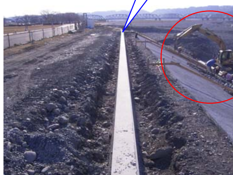
縦帯コンクリートと石張りの併行作業
