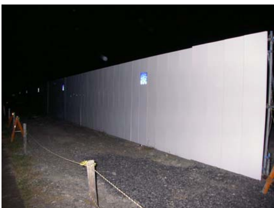
【万能板による仮囲い・照明設置】
