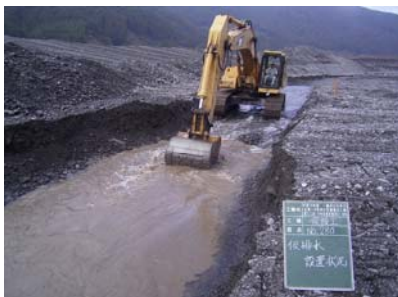
【仮設工(仮排水)】
