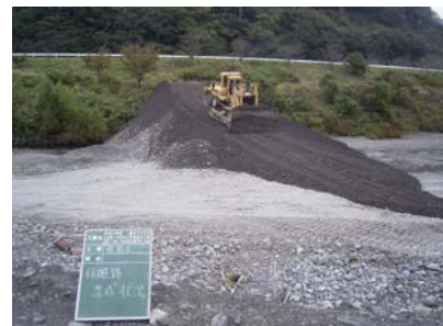
【仮設工(仮搬路)】
