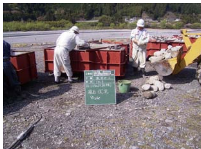
【根固工(ブロック製作)】
