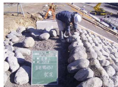
【法覆護岸工(石張工)】
