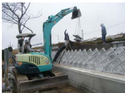
【ブロック積 作業状況(ブロック荷上げ)】
