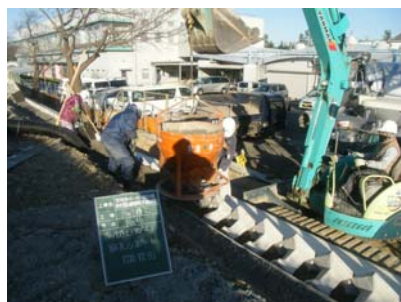
【ブロック積 作業状況(コンクリート打設状況)】
