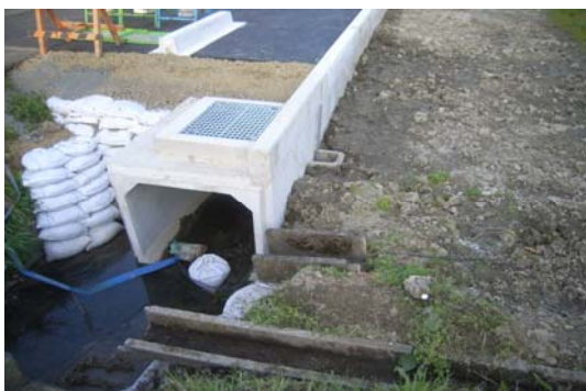
写真3 下流部 流末 新設ボックスカルバート
