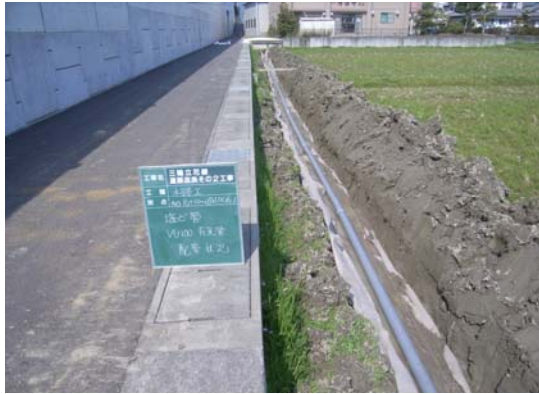
写真1 上流部 不織布・多孔管設置
