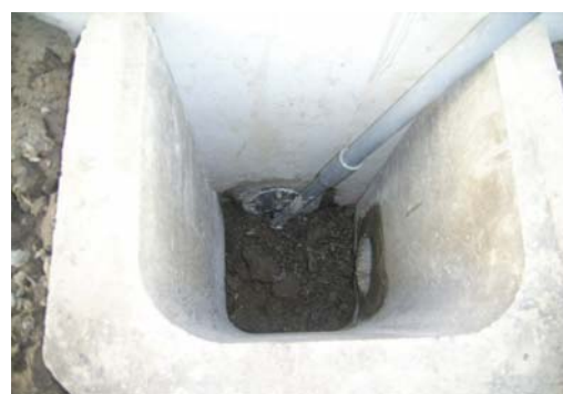
写真4 既設U型側溝再利用・分水栓
