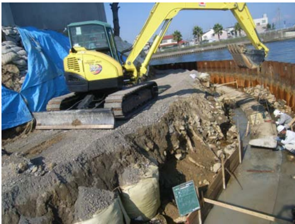
基礎コンクリート据付
