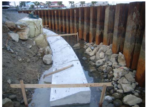
据付完了 全景
