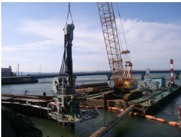
硬質岩盤クリア工法 (クラッシュパイラー)施工状況
