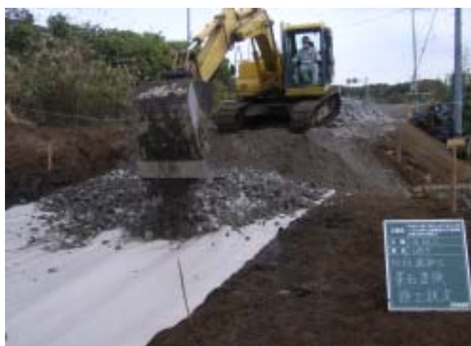
栗石置換えと長繊維不織布施工状況
