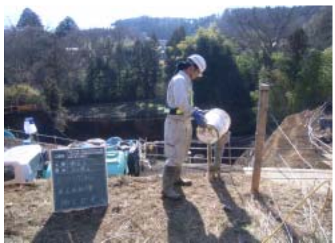
セメントミルク投入状況
