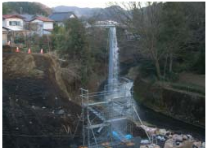
管を垂直に接続した状況
