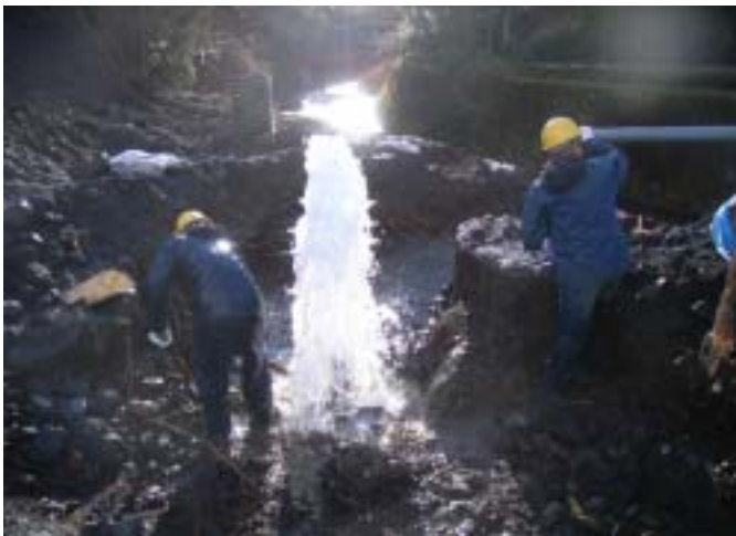
ケーシングからの噴水状況
