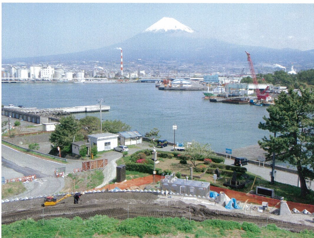
現場後方より施工箇所～田子の浦港～富士山を望む
