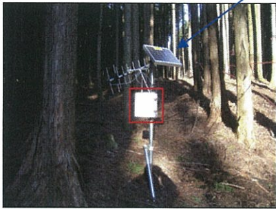
中継器設置状況
