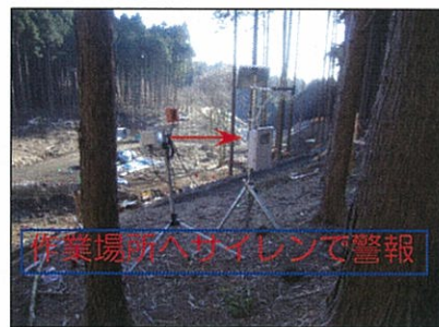
受信機設置状況
