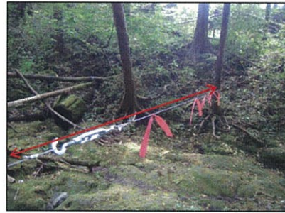
ワイヤー設置状況
