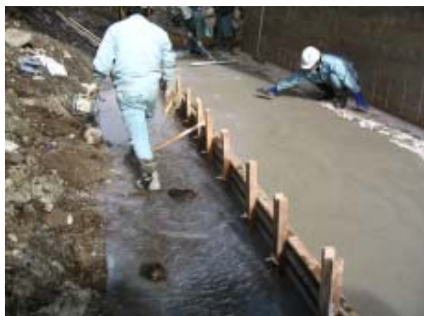
写真5 創意工夫 不織布マット設置及びコンクリート打設状況、にぎり確認
