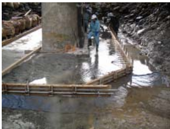
写真4 創意工夫 不織布マット設置及びコンクリート打設状況、にぎり確認
