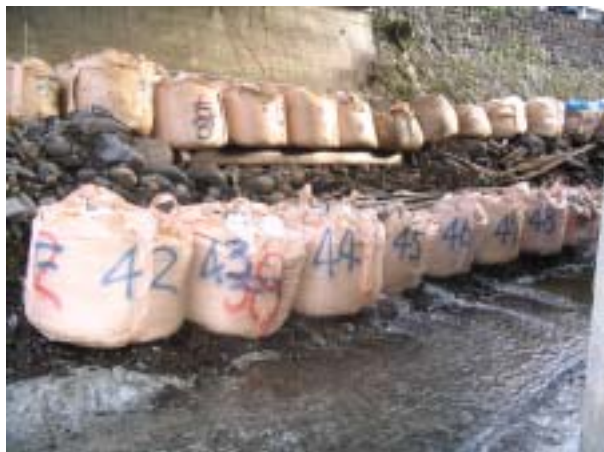
写真2 大型土嚢設置、流水状況
