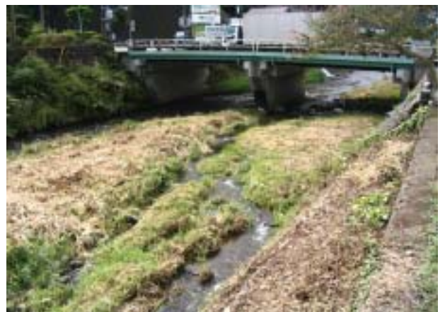
写真1 着手前 徳永川に架かる冷川大橋
