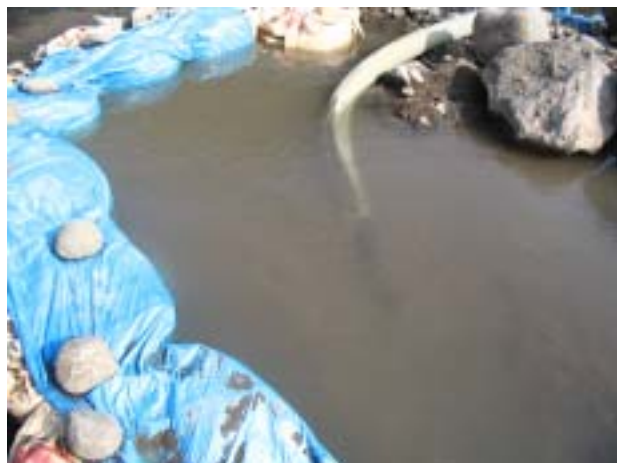
写真3 創意工夫 水中ポンプ排水口、かま場設置
