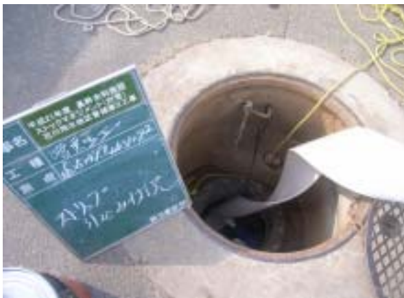
空気弁進入口
