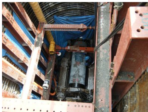
推進状況写真
