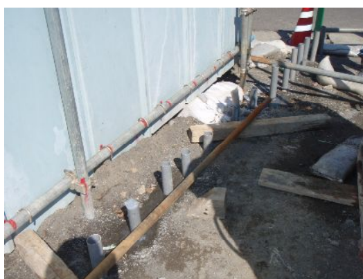
圧抜き塩ビ管設置状況
