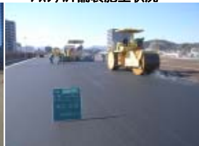
アスファルト舗装施工状況
