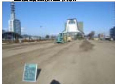
上層路盤施工状況
