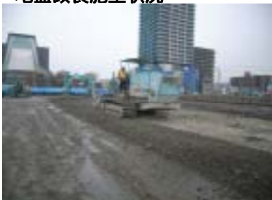
地盤改良施工状況
