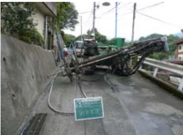
写真-2鉄筋挿入施工状況(削孔時)
