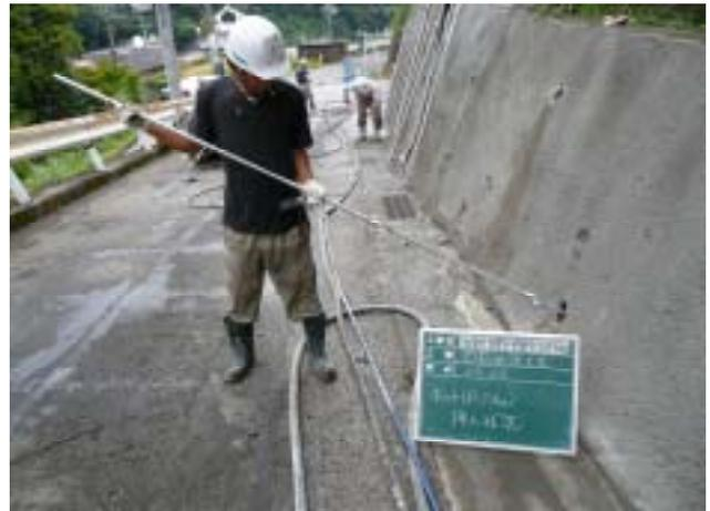
写真-3鉄筋挿入施工状況(鉄筋挿入時)
