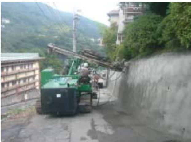
写真-2-1鉄筋挿入施工状況(削孔時)
