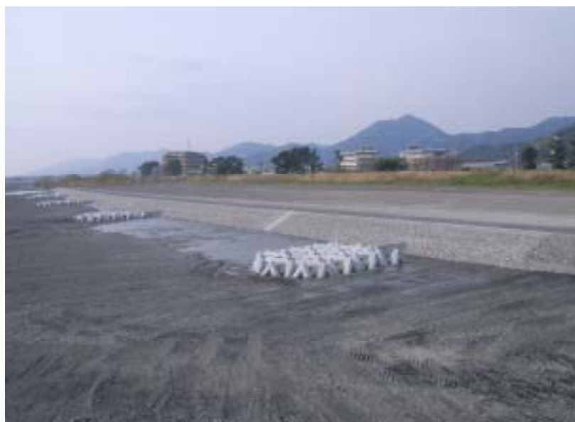
完成写真 全 景
