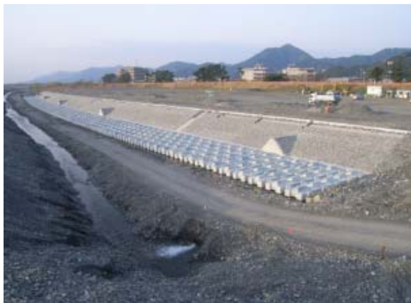
不可視部完了写真 全 景
