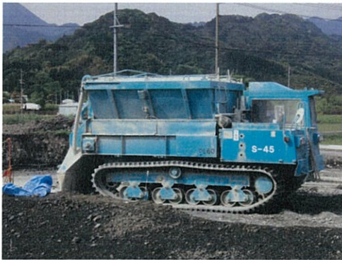
固化材散布状況
