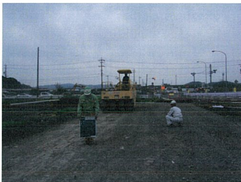
プルフローリング確認
