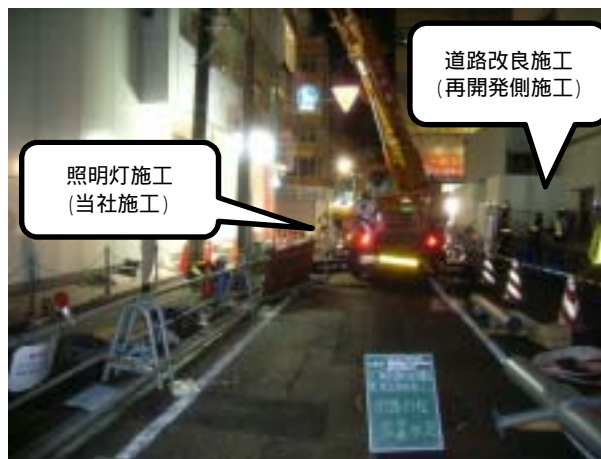
作業エリア調整による同時施工
