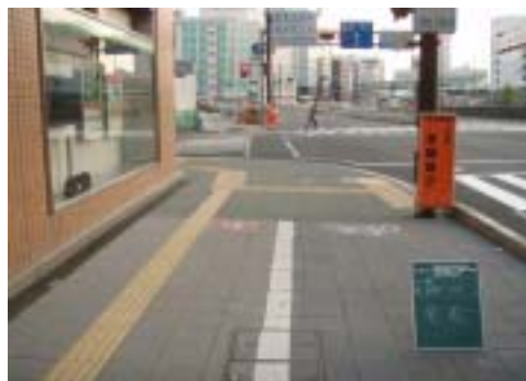
国道1号接続部完成
