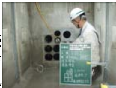
部分引き渡し検査の様子
