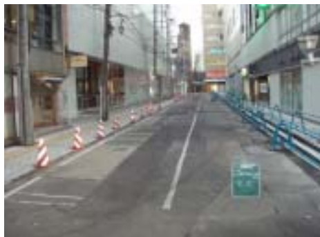
北面道路完成
