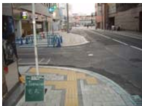
西面道路完成
