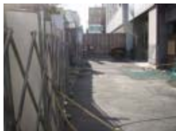
再開発ビル工事現場内(西面道路)
