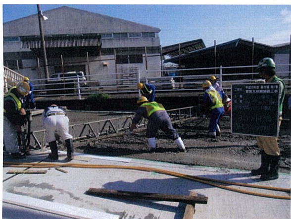
簡易フィニッシャー使用状況
