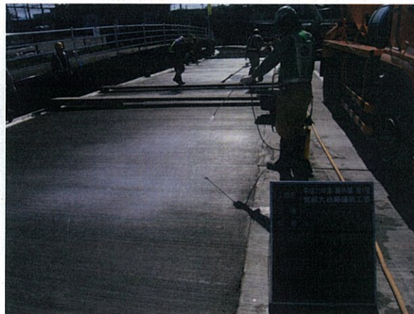
コンクリート初期養生
