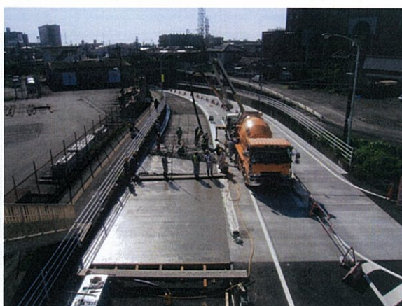
コンクリート打設状況
