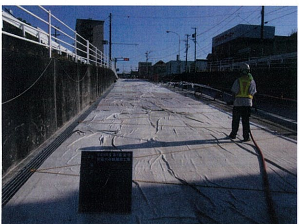
コンクリート後期養生
