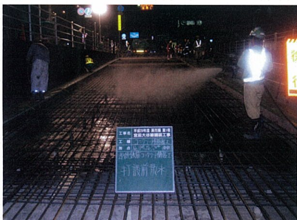
コンクリート打設前散水
