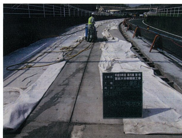
縦目地の施工(打設後期養生中)
