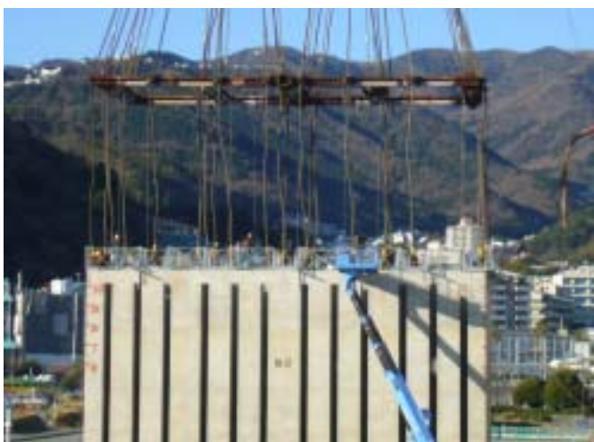
写真－３ 玉掛け作業
