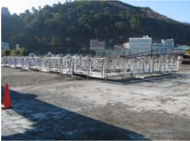
写真－１ 玉掛け用足場(仮設材)
