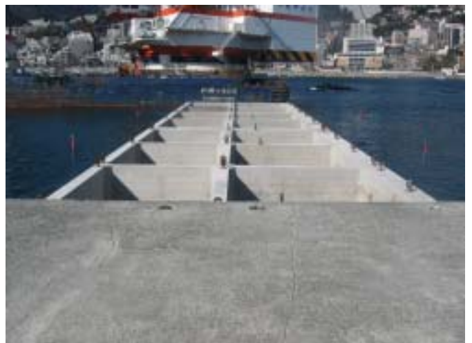
写真－５ 据付完了(２函)
