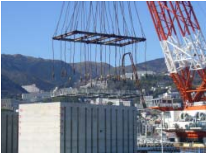
写真－２ 玉掛け用足場セット状況
