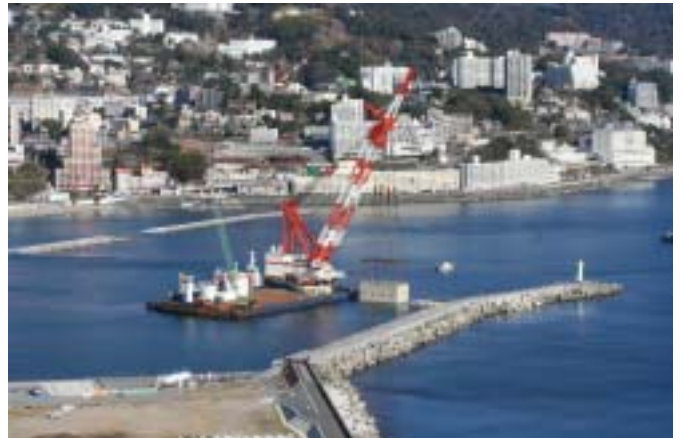
写真－４ 据付状況
