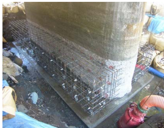
アンカー定着、鉄筋組立完了
