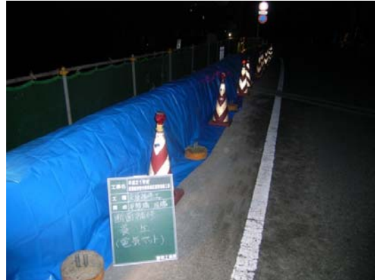
電熱シートの上にブルーシート
