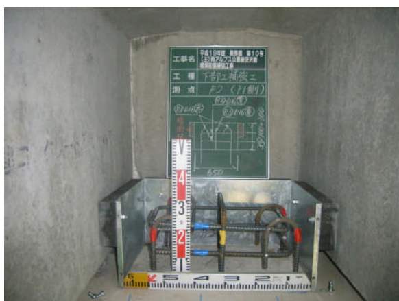
型枠及び緩衝材の設置完了
