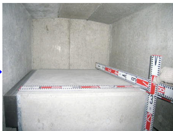
生コン打設完了
