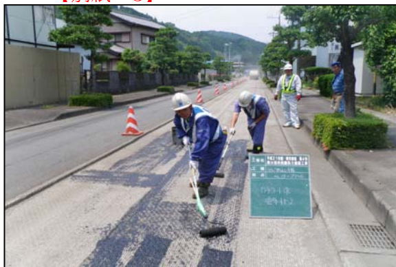
アスファルトプライマー塗布(カチコートSR) 0.30/m 2
