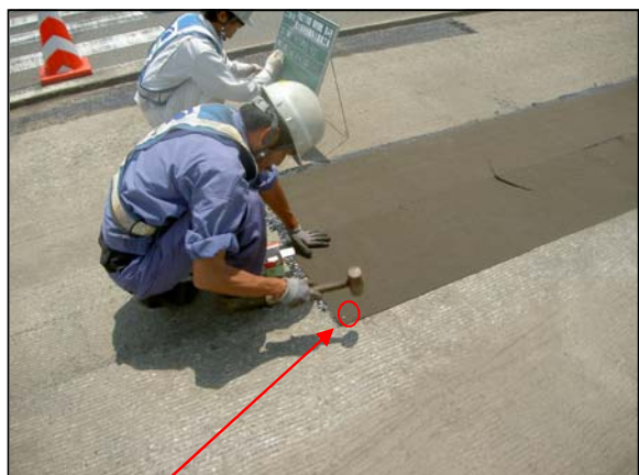
コンクリート釘にてシートを固定
