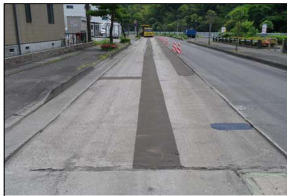
クラック防止シート設置状況 サミーシートW=500*15m*110巻使用 切削面に現れているクラック部にシートを設置
