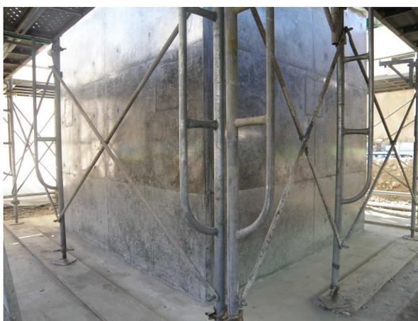
〔脱型枠完了 巻立てコンクリート 全景〕
