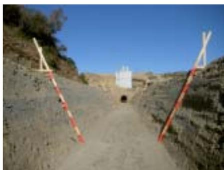
管路 溝型掘削完了
