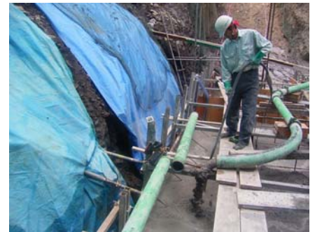
コンクリート打設状況
