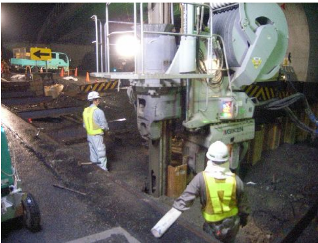
鋼矢板打込み作業
