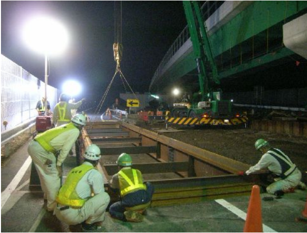
路面覆工設置作業状況
