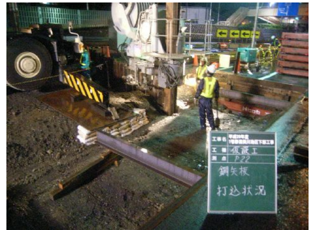
鋼矢板打込み作業
