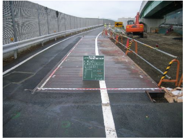
路面覆工設置完了
