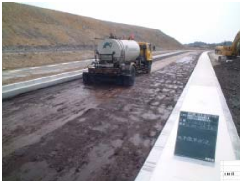
高浸透性乳剤散布状況
