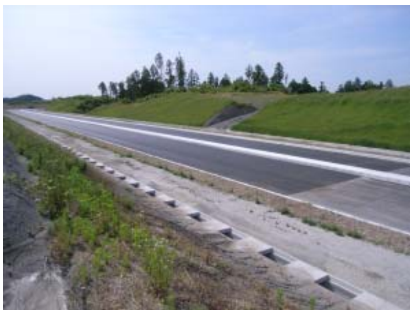
今回の施工写真(当工事は道路掘削から基層工まで)
