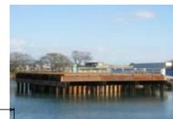
2. 仮栈橋支持杭と仮締切鋼矢板の杭芯間を1.6m離すことにより、クリアランスは1m程度となりパイプロハンマでの打込が支障なく安全に行えるように変更した。経済性を考慮した結果、仮栈橋上部工面積は当初216㎡から150㎡に大幅縮小した。
