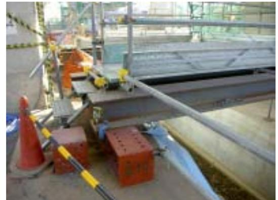
P164橋脚 (片側オープン掘削時の場合、山留め材を用いてH鋼の高さ調整を行った)
