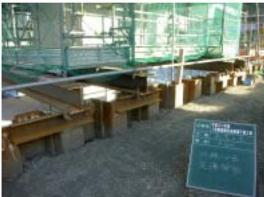
P164橋脚 (鋼矢板にチャンネルを溶接し、H鋼架台の水平を確保した)
