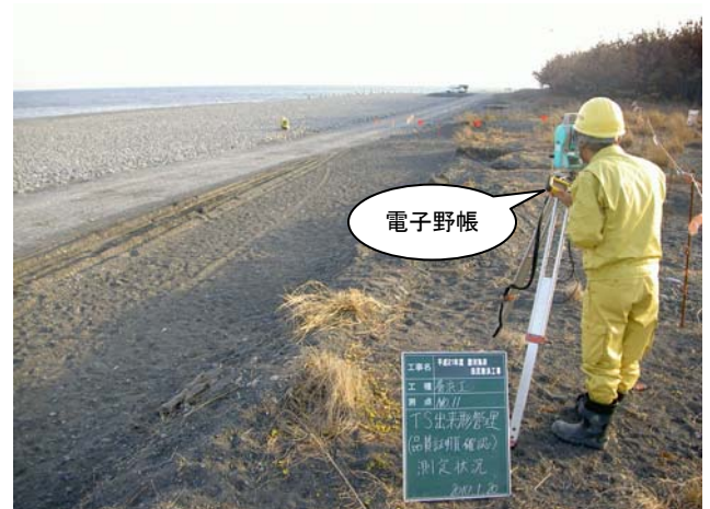
施工管理データを搭載したTSによる出来形管理状況
