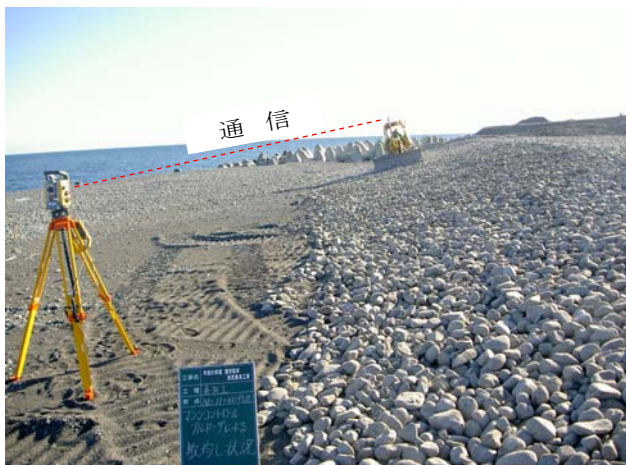
ブルドーザ搭載型マシンコントロールシステム施工状況
