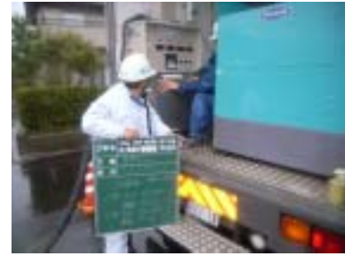
写真-8 1次硬化温度測定
