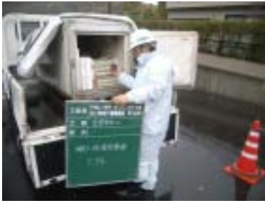
写真-7 納入時温度測定
