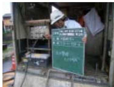
写真-6 内面補修圧力管理
