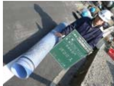
写真-2 破損管立会
