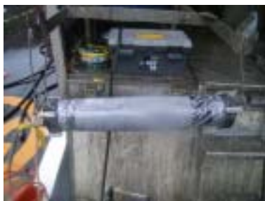
写真-6 内面補修
