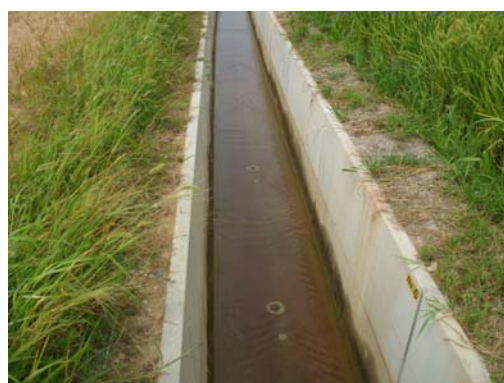
写真 2：ウィープホール設置後（拡大）
