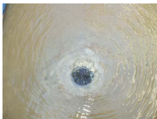
写真 2：ウィープホール設置後（拡大）
