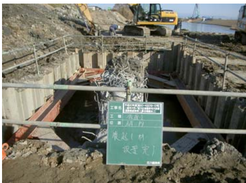
写真-2 山留材設置完了
