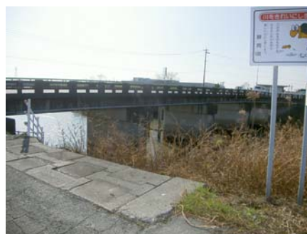
写真-1 着手前写真
