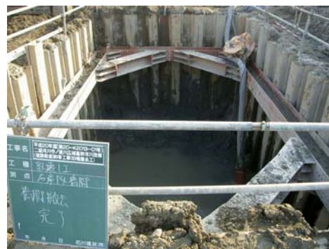
写真-3 橋脚取壊し完了
