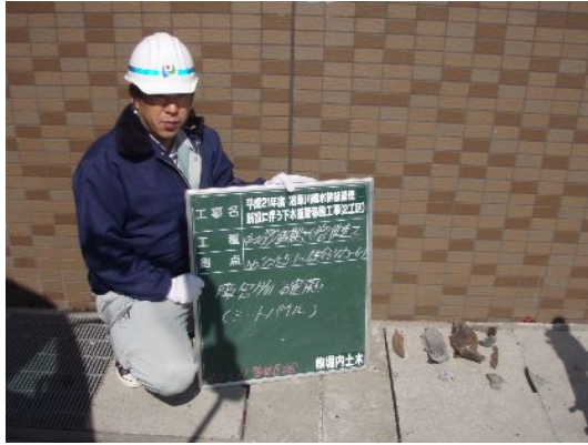
写真1 鋼矢板障害物確認
