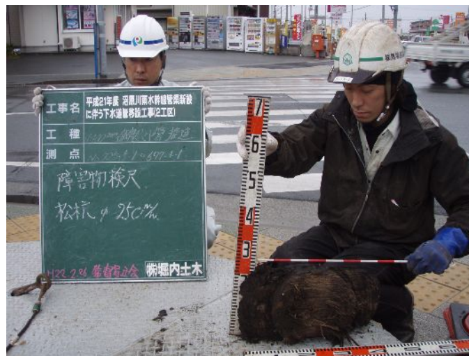
写真2 松杭障害物確認
