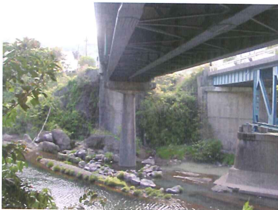
新小山橋 P1橋脚 着手前
