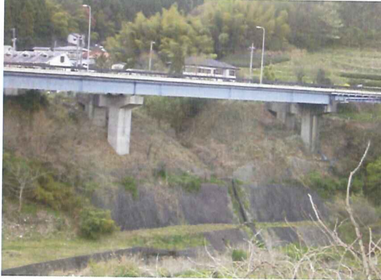
中島高架橋 P2、P3橋脚 着手前
