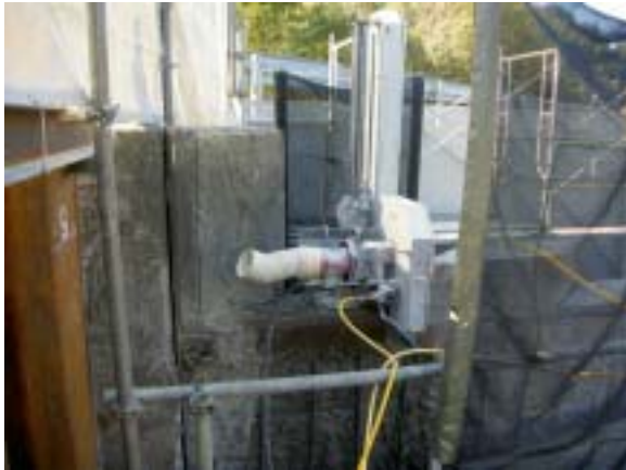
ワイヤーソーによる切断作業
