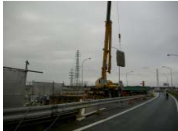
ラフタークレーンによる積み込み状況
